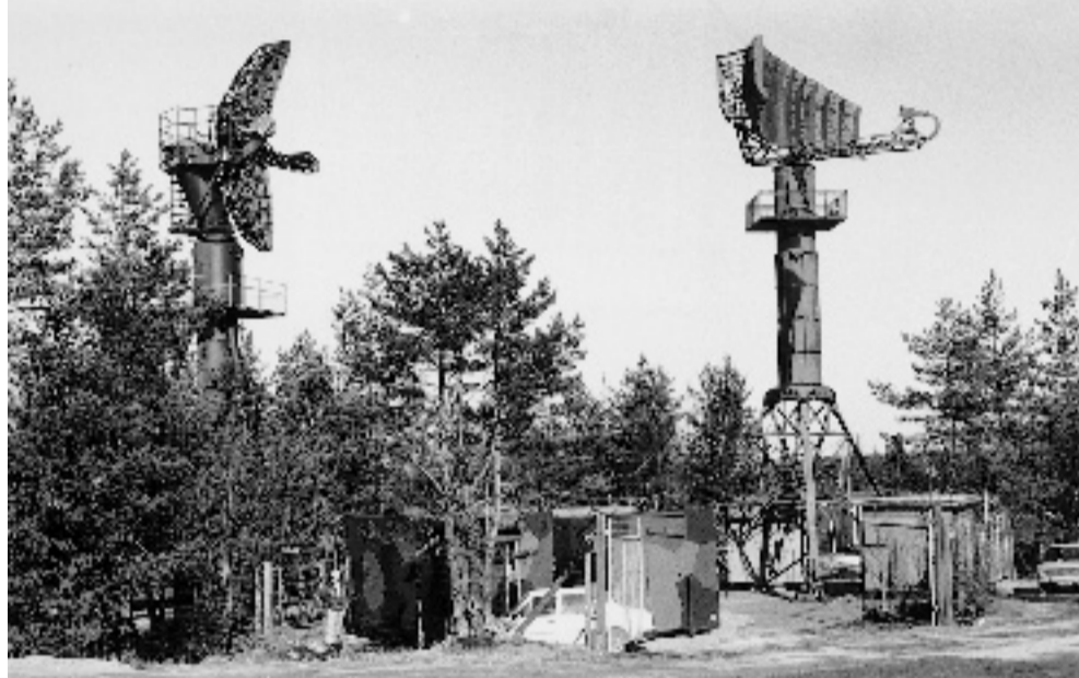
Kotimainen matalavalvontatutka (MVT) on hyvä esimerkki siitä, millaisia tuloksia voidaan saavuttaa pienekin maan resursseja yhdistämällä. Tuotekehitystyötä tehtiin VTT:llä puolustusvoimien ja SITRAn yhteisrahoituksella vuosina 1968–74. MVT-järjestelmän sarjavaiheen valmistus ja kokoonpano suoritettiin Viestikeskuskorjaamolla. 1980-luvun loppupuolella otetussa kuvassa vas. K-antenni ja oik. V-antenni sekä etualalla näyttölaite- ja lähetinkontit. – Kuva Puolustusvoimien Elektroniikkakeskuskorjaamo.
