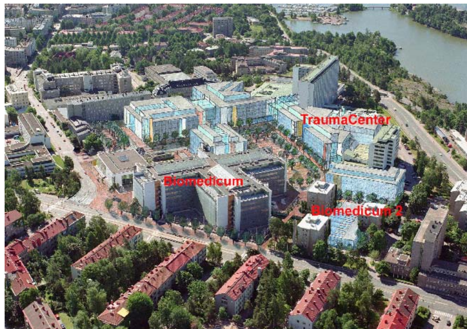
Kuva: Meilahden kampus-alue ja tulevat uudisrakennukset Biomedicum 2 ja TraumaCenter.
